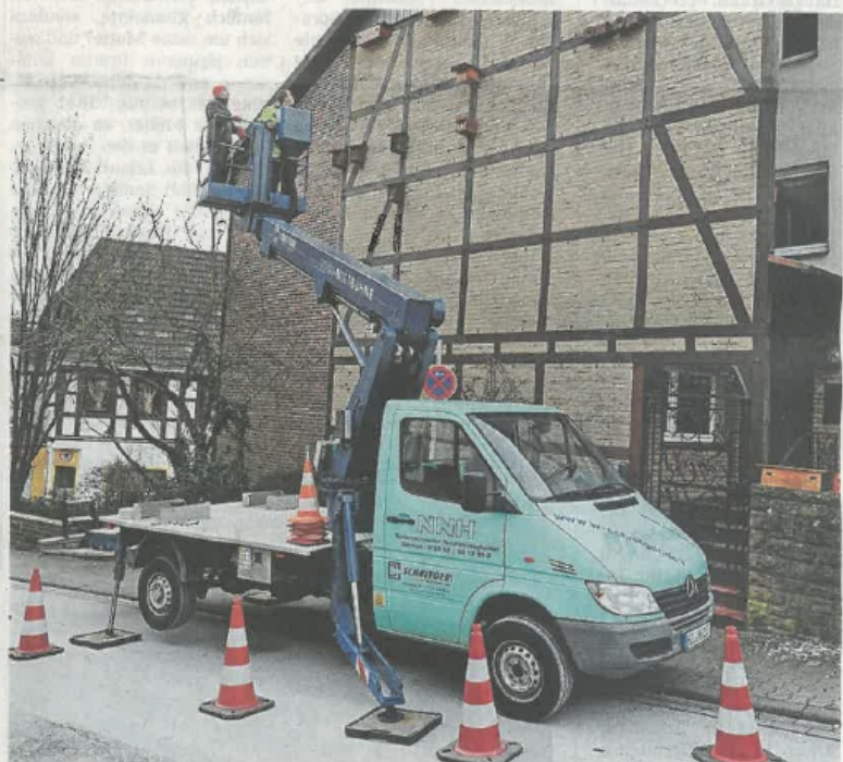
Die Bereitstellung eines Hubsteigers samt Mitarbeiter erleichterte die Arbeit der Naturschützer bei der Anbringung der Kästen enorm.
