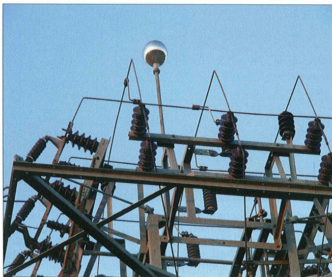
Bild 2 (links): Greifvogelabwehrkugel – hier auf Schaltermaststation montiert – als Vogelschutzmaßnahme nicht mehr zulässig
