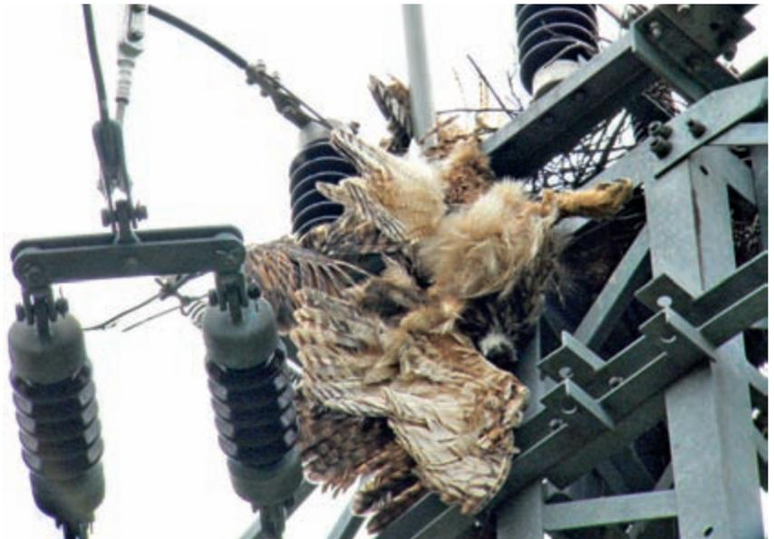
Mittelspannungsmast mit einem durch Stromschlag getöteten Uhupaar in Niederhausen an der Appel/Rheinland-Pfalz Juni 2012 vor Ablauf der Umrüstungsfrist.
