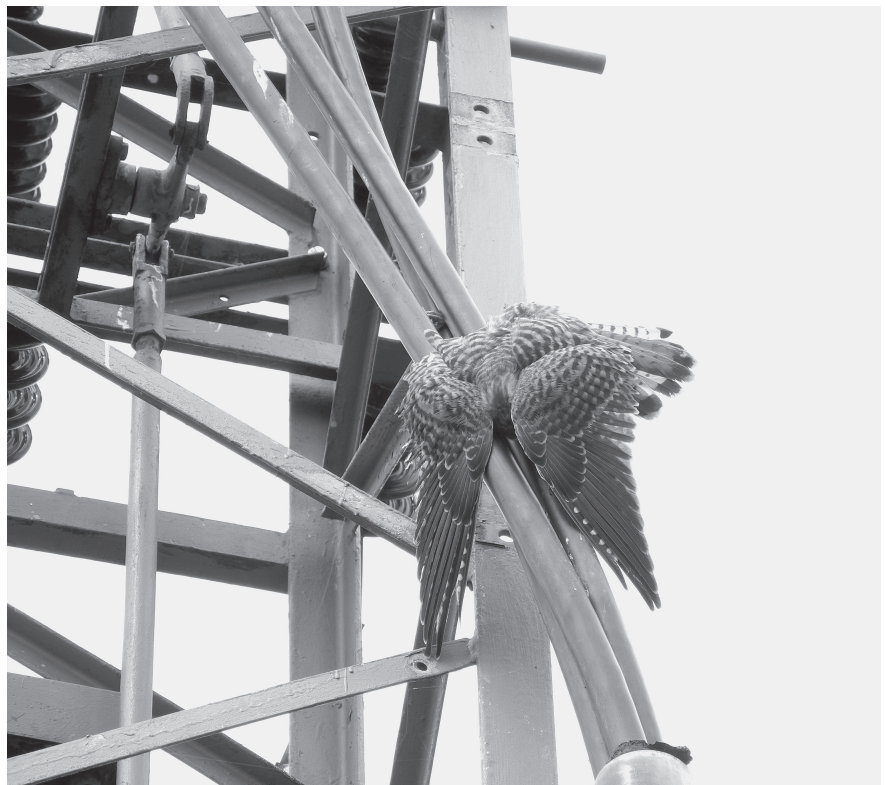
Abb. 2: Mittelspannungsmast und durch Stromschlag getöteter Turmfalke im Europäischen Vogel-schutzgebiete Halbinsel Eiderstedt/Schleswig-Holstein August 2013 (Stichprobe 10). Foto: Michael Knödler
