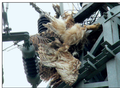
Abbildung 3: An einem Mittelspannungsmast vom Strom getötetes Uhu-Paar in Niederhausen an der Appel/Rheinland-Pfalz im Juni 2012 ein halbes Jahr vor Ablauf der gesetzlichen Umrüstungsfrist (Foto: MICHAEL KNÖDLER)
