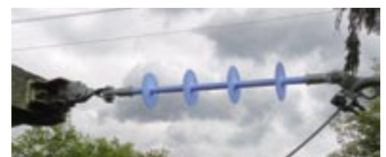
Langstabisolatoren mit 600 mm Isolationsstrecke für Nachrüstung und Neubau an Abspannmasten. Foto: W. Böhmer
