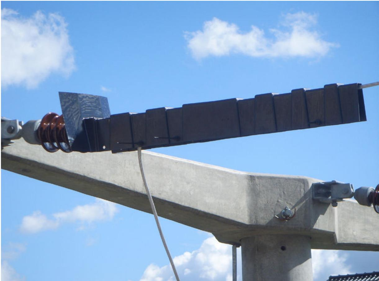
Foto 8: Für Nachrüstung: Abdeckungen für Seilklemmen an Abspannmasten sind eine wirksame Vogelschutzmaßnahmen. Abdeckungen sind auch für doppelte Isolatoren möglich.
