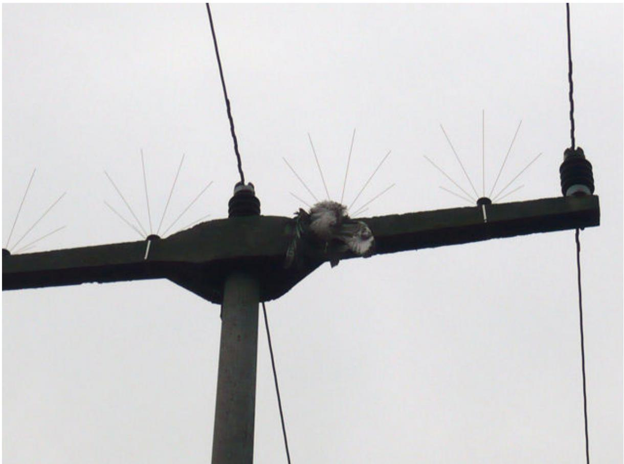
Abb. 11: Die Montage von Büschelabweisern statt Abdeckhauben kann wie hier im Bild fatale Folgen haben. Zwischen Büschelabweiser und Stromquelle traf den Bussard der Schlag. Der Vogel ist dann im Büschelabweiser hängen geblieben.
