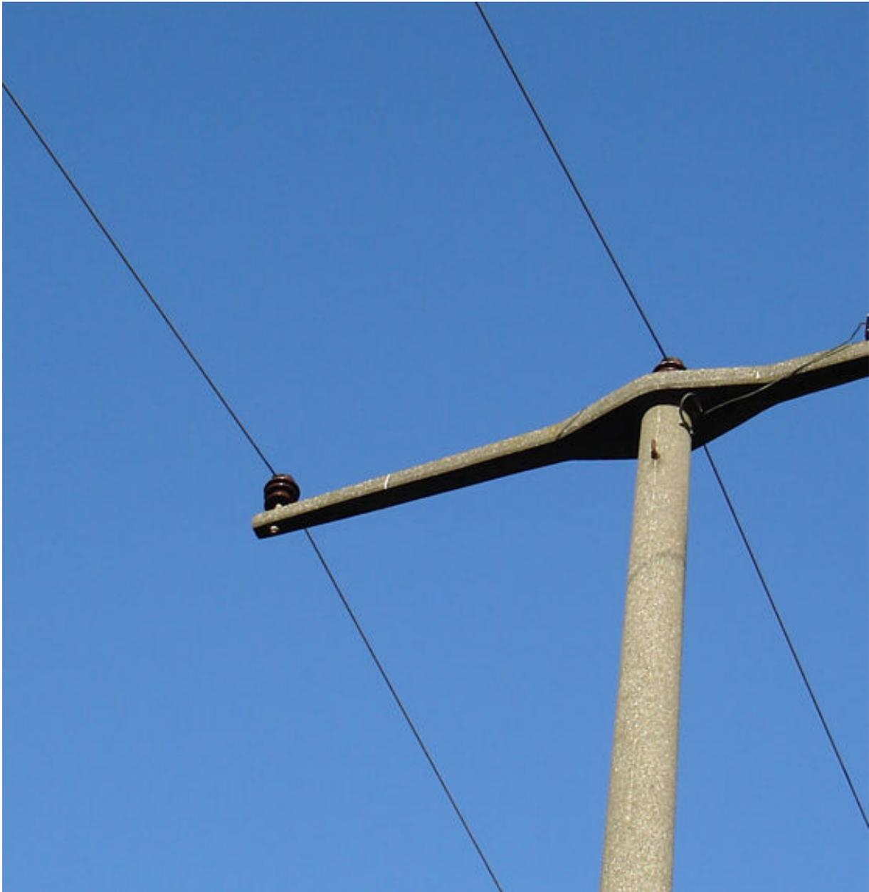
Abb. 9: Bei Neubau: Stehende Isolatoren sind auf leitfähigen Masten (Stahl oder Beton mit nicht isolierter Traverse) unzulässig.
