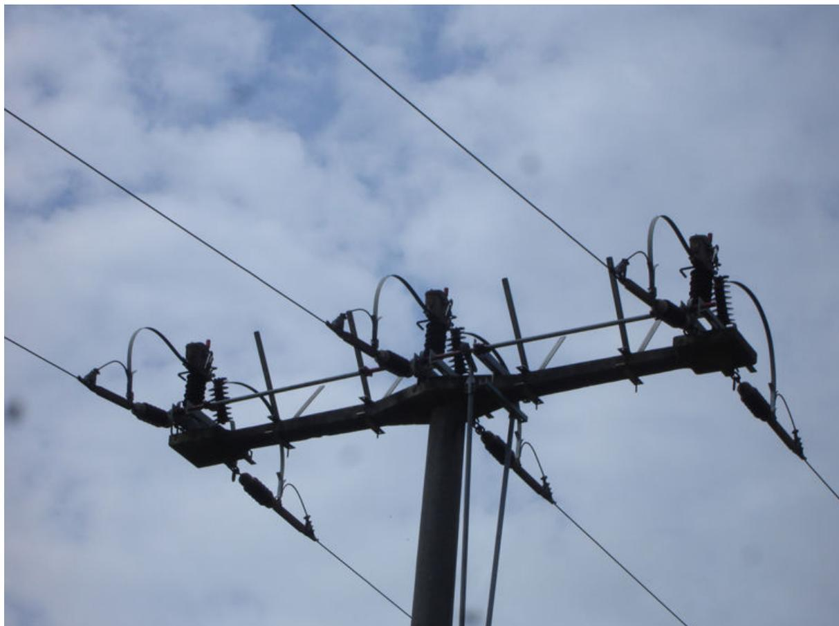
Abb. 1: Untauglich: V-förmige Vogelabweiser (hier zwischen den Schalterelementen)
