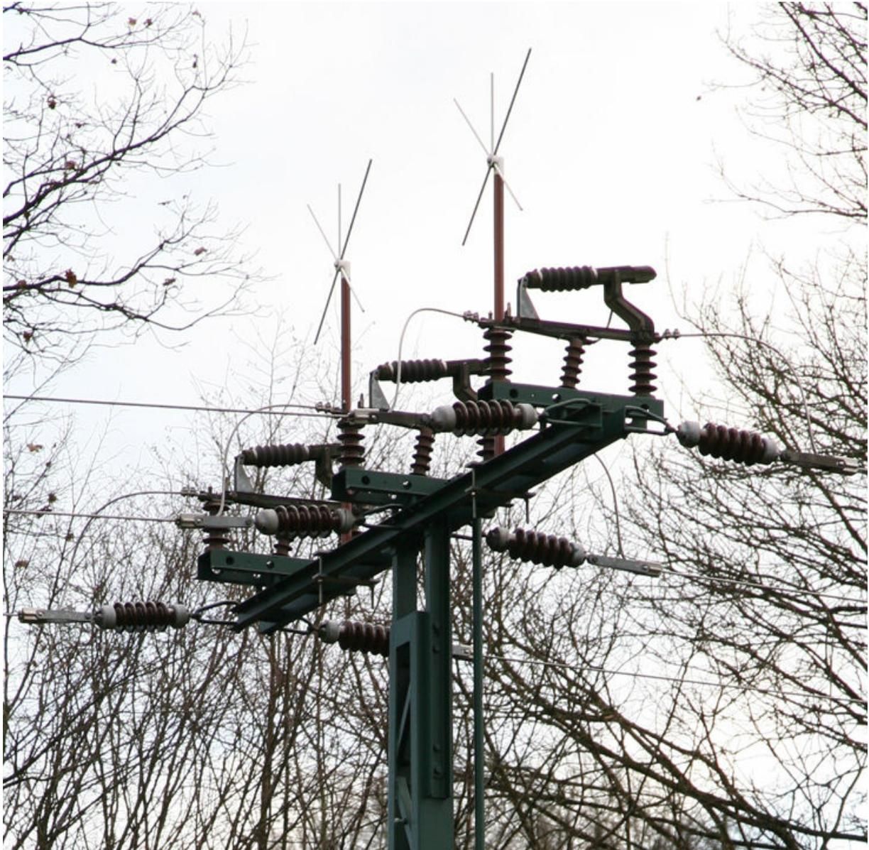
Abb. 7: Masten mit Schalter auf dem Mastkopf dürfen nicht mehr errichtet werden. Bei alten Masten dieses Typs sind „Andreaskreuze“ (hier im Mastschalter) zulässig.
