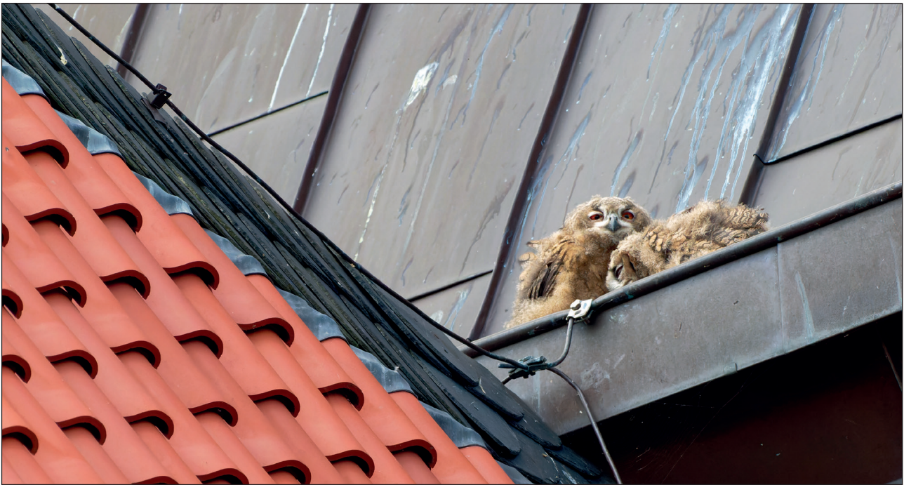
Abbildung 3: Zwei Junguhus in der Dachrinne des Kirchturms am 11.06.2022; zu sehen ist auch der Dachfirst des Kirchenschiffs mit Blitzableiter (Foto: ANDREAS KELLER)
