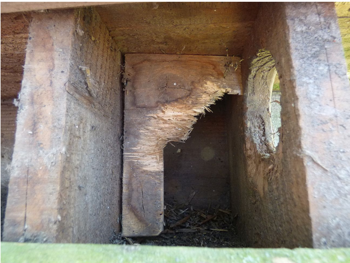
Abbildung 3: angefressener Marderschutz
